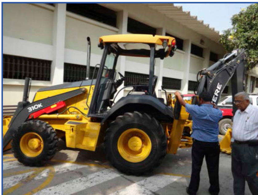
Adquisición de una retroexcavadora para dar mantenimiento al Campus Gustavo Galindo.
