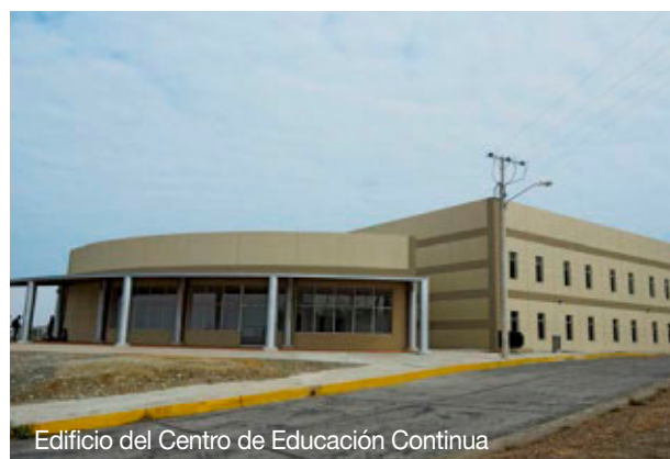
Adecuación Vicerrectorado Académico
