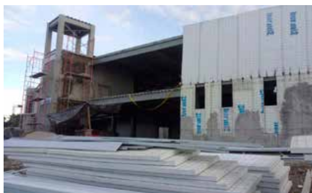
Construcción del edificio de postgrado Área STEM
