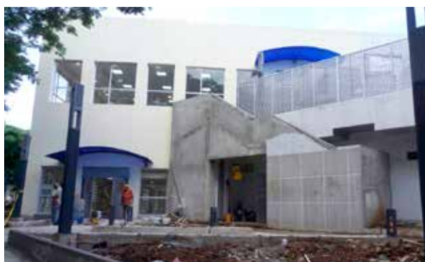
Remodelación y ampliación del comedor de Ingeniería
